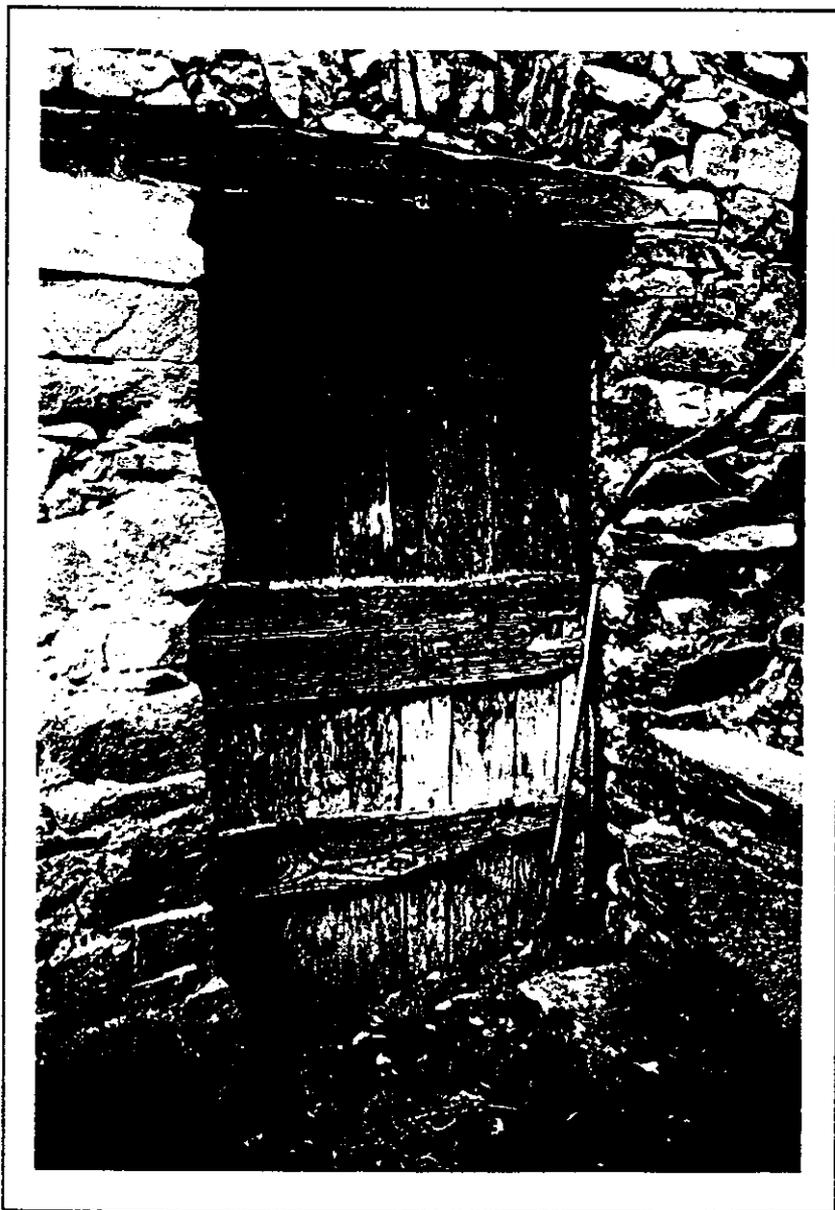
In questo tipo di accesso si può notare l'architrave costituita da un travetto in legno squadrato di dimensioni variabili a seconda della luce del foro.
